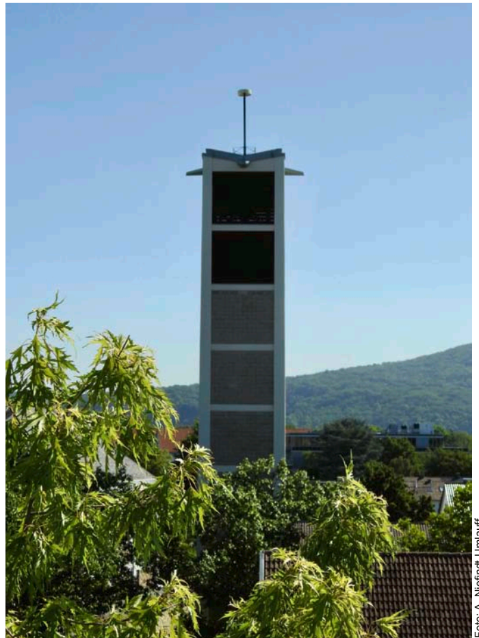
Blick auf den Glockenturm von der Dachterrasse des Amos
